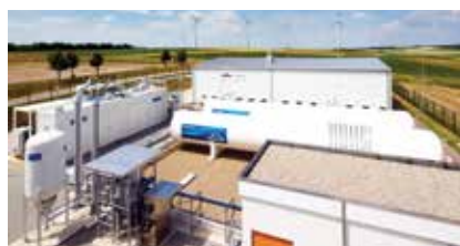
Hình 5. Khu lưu trữ sản phẩm hydrogen xanh và làm khô [4].
