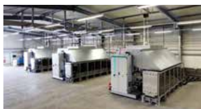
Hình 3. Hệ thống PEM của Siemens [4].
