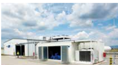
Hình 4. Container máy nén hydrogen xanh [4].
